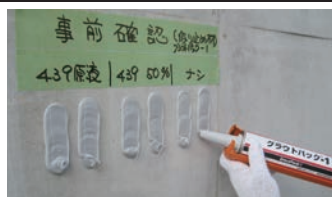
仮止めシールのテスト施工
