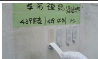
剥離性・接着性・シミ跡確認
