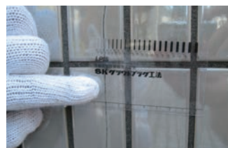
3. ひび割れ測定
