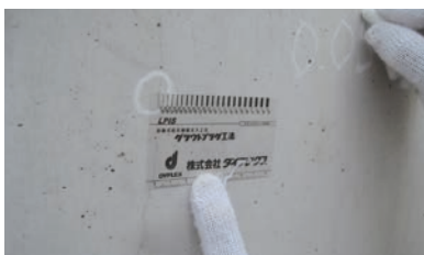
1. 事前確認・ひび割れ調査
