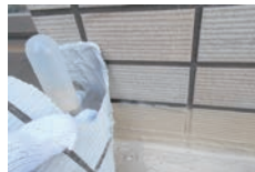
グラウトパック®-439 25% (希釈) 注入後仮止めシール材の撤去
