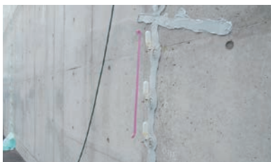
7. エポキシ樹脂の硬化養生
