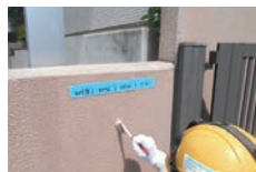
グラウトパック®-439 の塗布 (原液・50%・25%水希釈・なし)
