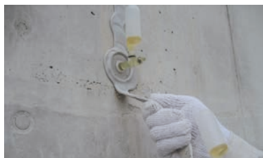
8. プラグと仮止めシール材の撤去
