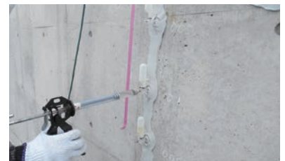
6. エポキシ樹脂注入
