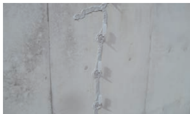
5. 仮止めシール材の硬化養生
