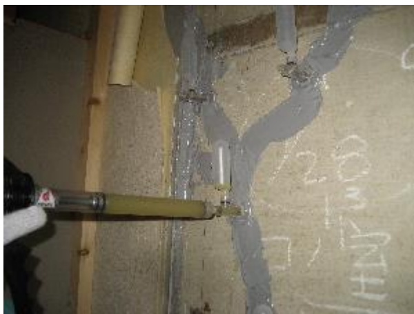
戸境壁のひび割れ注入施工例
