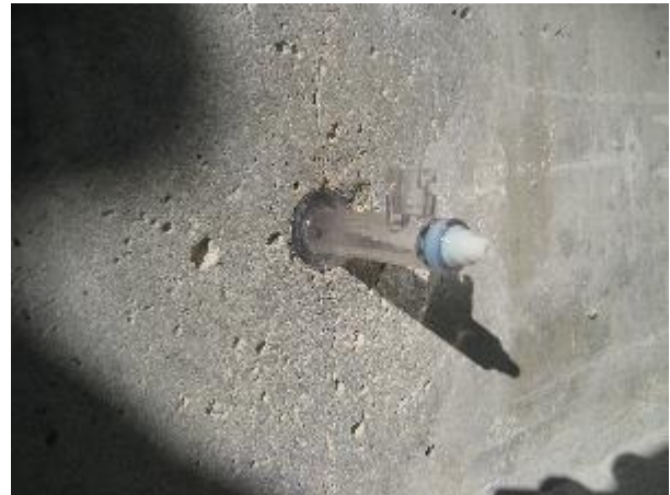
注入器具を打ち込みした状態 (注入器具:グラウトプラグSS)
