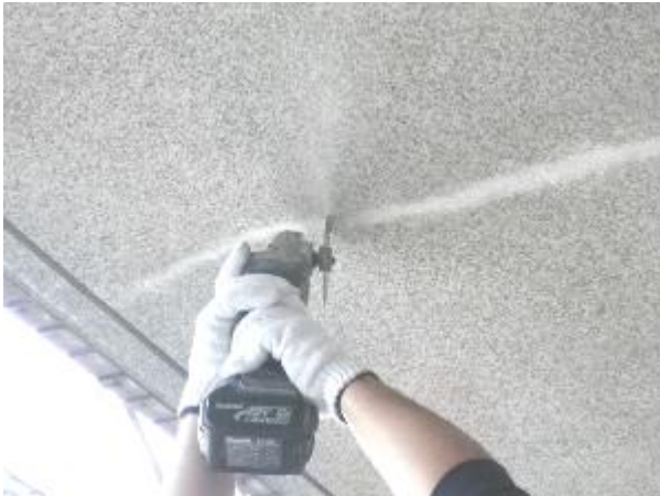
マンション共有通路の上裏面 ひび割れ(エフロ)注入器具取付け箇所 コンクリートカッターで隙間を確保
