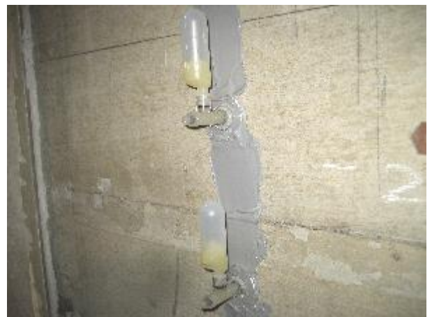
戸境壁のひび割れ注入施工例
