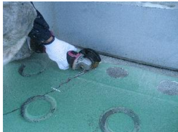
スロープのひび割れ表面が塵等で詰まっている ひび割れ注入器具取付け箇所を コンクリートカッターで隙間を確保
