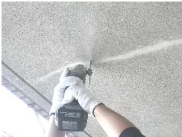
マンション共有通路の上裏面 ひび割れ注入器具取付け箇所 コンクリートカッターで隙間を確保
