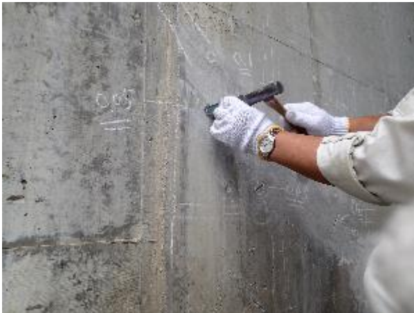
専用の打ち込み棒で注入器具を打ち込み
